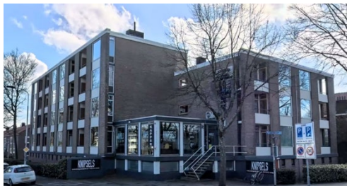
Figuur 5 Het gebouw en kapsalon dat wordt herontwikkeld
