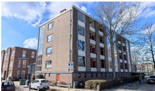
Figuur 1 Het gebouw dat herontwikkeld wordt
